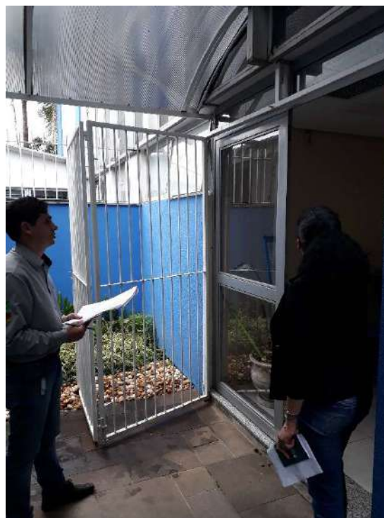
Figura 2 - Esquadria e grade a serem retiradas para readequação no pavimento térreo. (foto 02)
