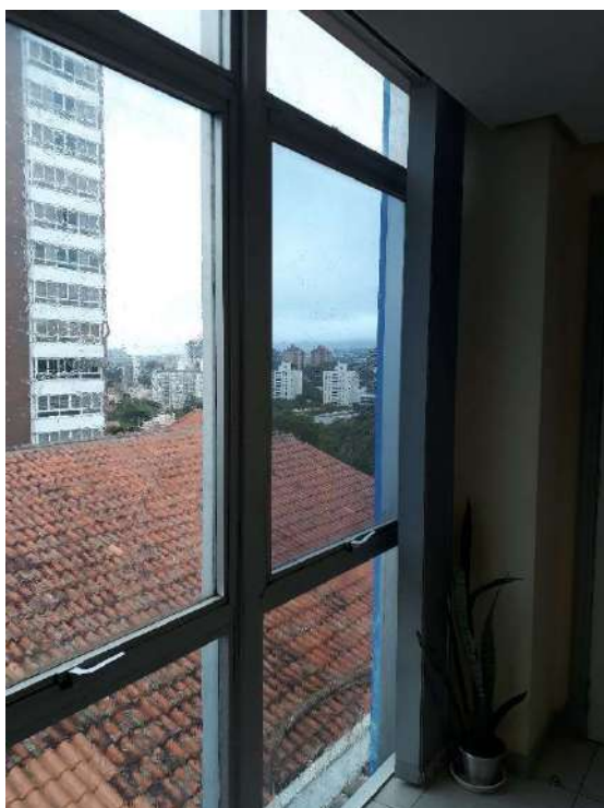
Figura 3 - Esquadria no 2º e 3º pavimento a qual será retirada 01 (um) perfil de alumínio para adequação de porta corta-fogo (foto 01)
