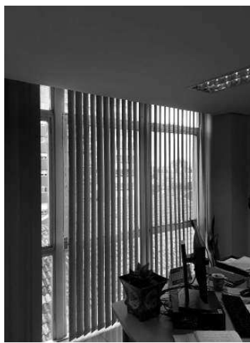
Figura 4 - Esquadria no 2º e 3º pavimento a qual será retirada 01 (um) perfil de alumínio para adequação de porta corta-fogo (foto 02)
