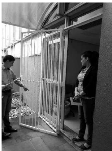
Figura 1 - Esquadria e grade a serem retiradas para readequação no pavimento térreo. (foto 01)
